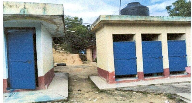
Foto 4: Mantenimiento a puertas.
