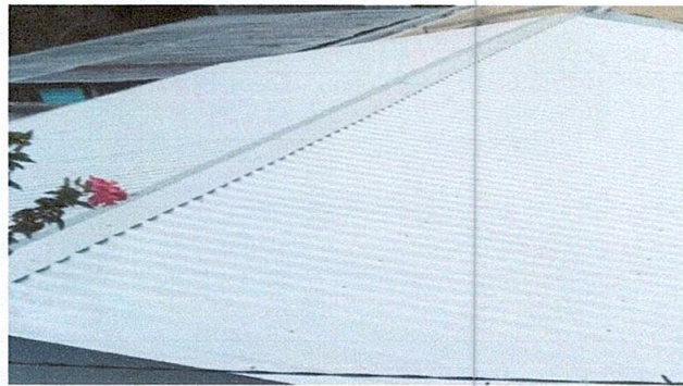
Foto 3: Sustitución de capote de lámina por capote calibre 24.
