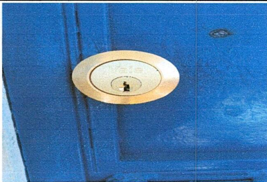
Foto 5: Sustitución de chapa de metal.
