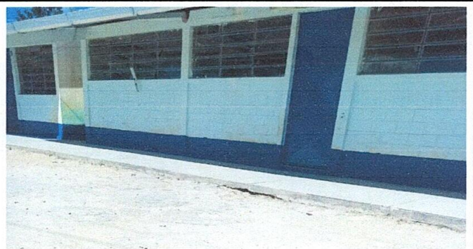
Foto 6: Pintura en muros exteriores.
